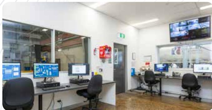
При использовании персонального компьютера для контроля системы FlexMix Вы получаете полное обозрение процесса производства в режиме реального времени на блок-схеме с индивидуально заданными параметрами. Такие действия как смена сырья или рецептуры, проверка производственных данных или запаса сырья выполняются
